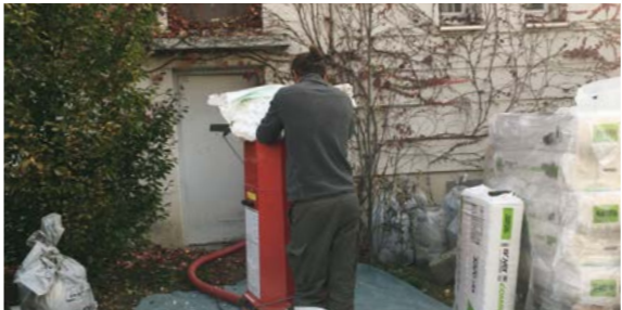
Isolation de l'immeuble locatif sur la place de la mairie fin 2021
