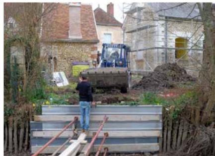
**Mars** : Deux trous de part et d'autre du bief ont été creusés à la pelleuse pour y couler du béton. Ces fondations vont accueillir la passerelle qui accèdera aux Balcons de l'Indrois. Cette opération a nécessité d'ouvrir les vannes pour abaisser le niveau de l'eau et travailler en toute sécurité.
