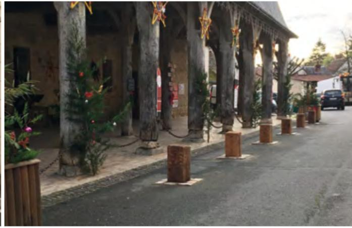
Pose de plots en bois brut devant les halles afin d'éviter le stationnement. Ces bornes sont amovibles pour laisser passer les véhicules utiles au marché ou aux différents usages de l'endroit. Le bois brut en vieillissant prendra la même teinte que les poteaux de la halle.
