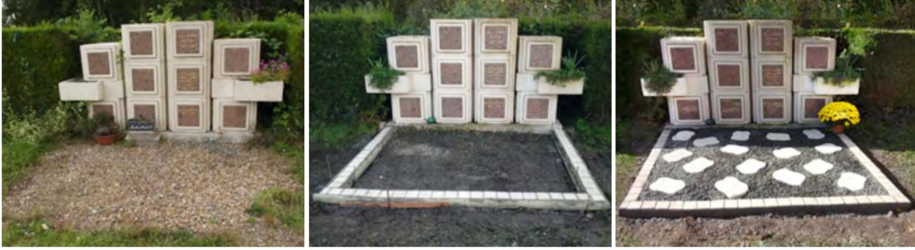
Un encadrement de pavés blancs a été scellé... ...puis on a déposé des gravillons gris et des pas japonais sur une couche de géotextile
