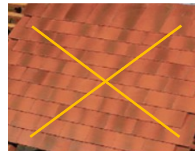
Tuiles plates trop rouges et trop régulières, non adaptées au village de Montrésor
