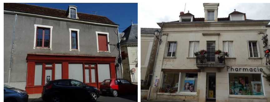
Devanture en applique (à gauche), sur un bâtiment ancien dénaturé et transformé. Devanture en feuillure (à droite), avec une enseigne en bandeau.
