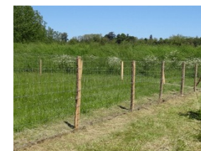
Grillage à mouton posé sur piquets bois.
