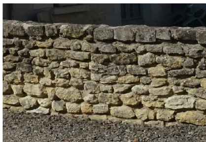
Mur en moellons équarris et pierre de taille plate en saillie en chapeau
