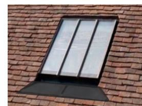
Verrière de toit encastrée avec des montants redécoupant le vitrage pour lui donner les proportions verticales
