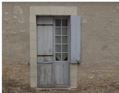
Porte avec volets extérieurs dans un gris bleu passé (bâti rural dans le centre-bourg)
