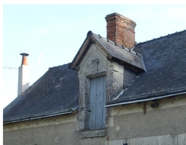
Lucarne pierre de taille en bâtière et pendante
