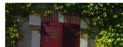
Mélange brique et enduit lissé dans les encadrements
