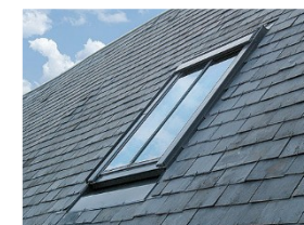
Châssis de toit encadré avec un montant redécoupant le vitrage en deux parties verticales
