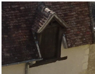
Lucarne pendante (sur la façade) avec toiture en bâtière
