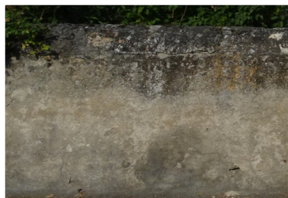
Mur maçonné traditionnel en moellons de calcaire avec chapeau arrondi (moellons hourdis au mortier de chaux)
