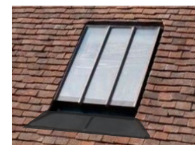
Verrière de toit encadrée avec des montants redécoupant le vitrage pour lui donner les proportions verticales
