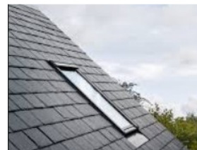
Châssis de toit simple encastré dans le plan de la toiture et ne présentant pas de saillie par rapport au matériau de couverture
