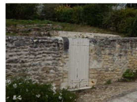
Mur traditionnel en moellons de calcaire avec chapeau arrondi : il est possible de remonter un mur neuf avec un parement en moellons
