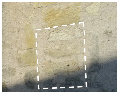
Baie bouchée qu'il est possible de restituer
