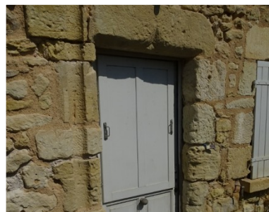
Baie avec linteau à accolade, porte avec volet bois extérieur
