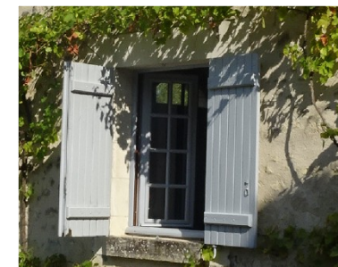
Volets à assemblage classique sans « échape », en bois peint
