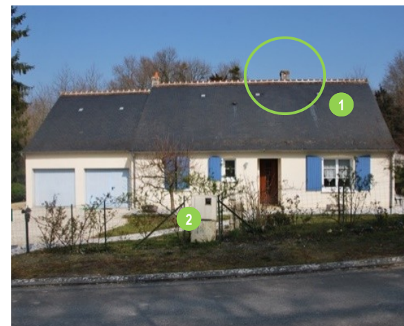
Exemple de couverture (1) réalisée en ardoises naturelles avec un faitage à crête et embarrure (des tuiles rondes scellées sur un mortier de chaux), les souches de cheminée ne sont pas aussi larges que les cheminées anciennes en brique, mais sont maçonnées. Le coffret technique (2) pourrait être intégré dans un coffrage bois pour améliorer son insertion et poursuivre le travail de clôture initié avec la haie vive.
