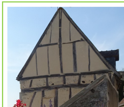
Pan de bois destiné à être enduit, le bois est purement structurel et ne présente aucun décor
