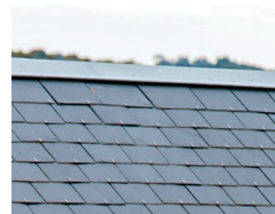
Exemple faitage en zinc sur une couverture en ardoise (constructions nouvelles uniquement)
