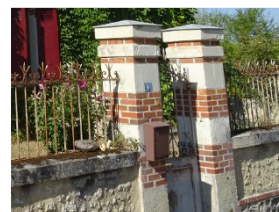
Mur bahut surmonté d'une grille et piliers en briques et pierres
