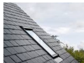
Châssis de toit simple encadré dans le plan de la toiture et ne présentant pas de saillie par rapport au matériau de couverture
