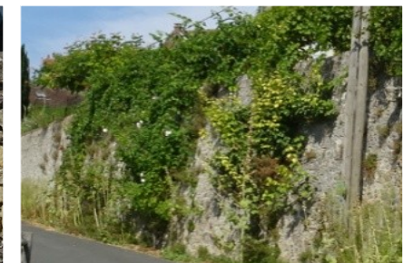
Mur de clôture en moellons, en grande partie végétalisé (veiller à la solidité des joints)
