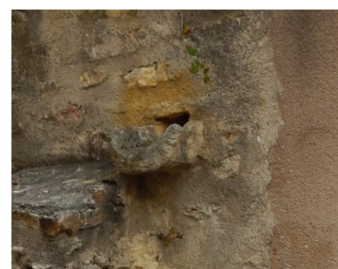
Gouttière (gargouille) sculptée dans la roche
