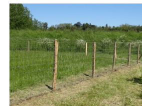
Grillage à mouton posé sur piquets bois.
