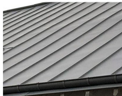
Exemple d'une couverture en zinc patiné posé à joint debout.
