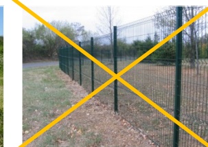
Le treillis soudé est inapproprié pour l'environnement rural, et souvent trop haut.
