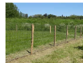
Grillage à mouton posé sur piquets bois.
