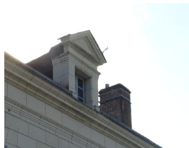
Lucarne classique avec fronton triangulaire en pierre de taille
