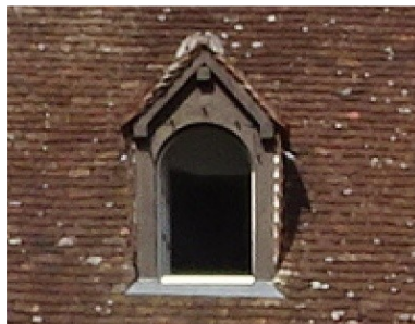
Lucarne à deux pentes simples, dite lucarne « jacobine »
