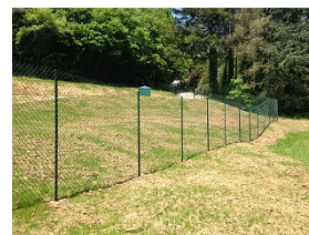
Exemple de grillage simple torsion métallique et de teinte foncée.
