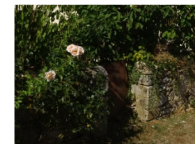
Muret bas parement moellons doublé d'une haie vive
