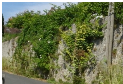
Mur de clôture en moellons, en grande partie végétalisé (veiller à la solidité des joints)
