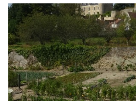
Mur maçonné édifié en limite séparative et séparant deux jardins le long de l'Indrois. Un tel mur peut être prolongé
