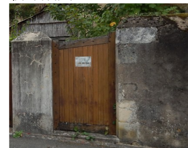
Portail bois à lames verticales, de teinte brune
