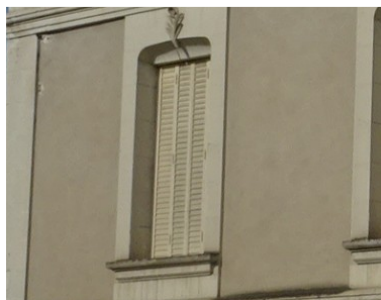
Encadrement en pierre de taille, jambage droit et linteau à arc surbaissé
