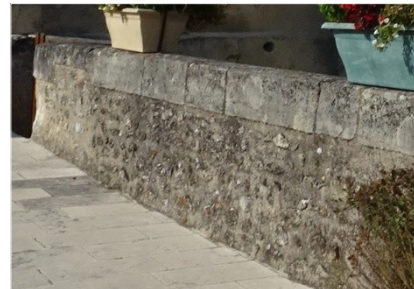
Mur de moellons couvert avec un chapeau en pierre de taille
