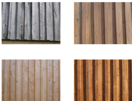
Exemples de bardage bois à liteaux couvre-joint, à lames plus ou moins larges
