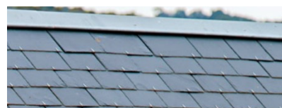
Exemple faitage en zinc sur une couverture en ardoise (constructions nouvelles uniquement)
