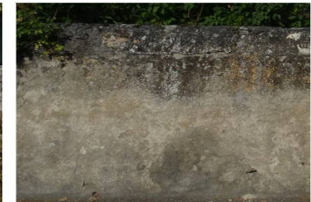
Mur maçonné traditionnel en moellons de calcaire avec chapeau arrondi (moellons hourdis au mortier de chaux)
