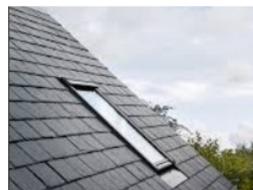
Châssis de toit simple encastré dans le plan de la toiture et ne présentant pas de saillie par rapport au matériau de couverture
