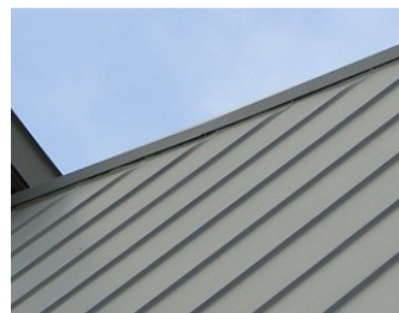
Exemple de bacacier de teinte gris ardoise, imitant le zinc à joint debout.
